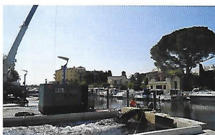
Dragage annuel et opération de curage, ici au Port du Riou.
