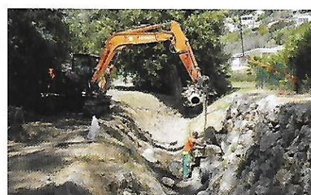
Nettoyement des avaloirs et dessableurs, ici dans le vallon de la Théoulière.
